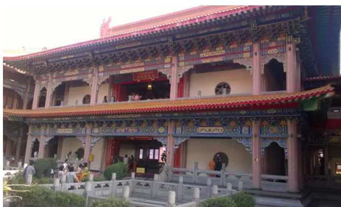
ภาพที่ 8 วิหารสุขาวดีหมื่นพุทธและวิหารพระโพธิสัตว์กวนอิมปางพันนครพันกร วัดบรมราชาวิทยาลัยกอนุสรณ์ นนทบุรี
