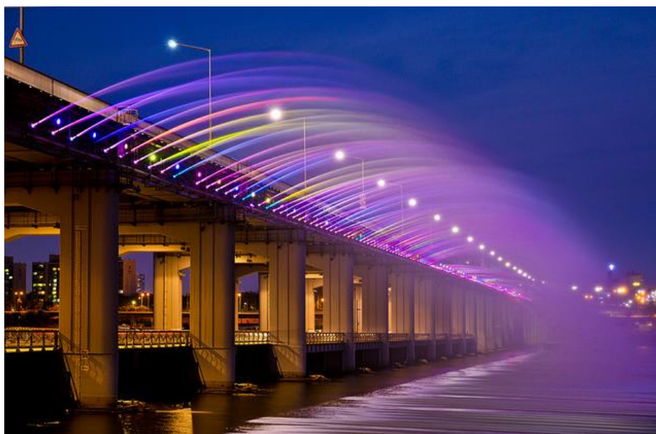
ภาพที่ 47 สะพานสายรุ้ง
