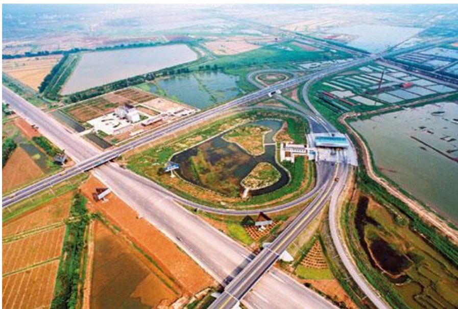
ภาพที่ 11 โครงการก่อสร้างทางด่วนมณฑลฝูเจี้ยนของจีน ปี 2555
