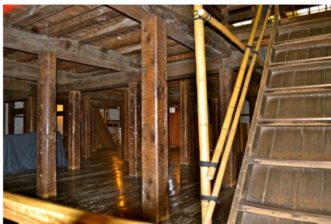
ภาพที่ 39 ภายในปราสาทมัตสึโมโตะที่สร้างด้วยไม้ทั้งหมด
