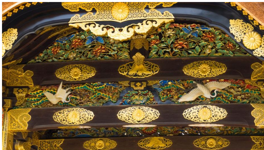
ภาพที่ 64 งานแกะสลักอันวิจิตรงดงามบนประตูดูคารามอน (Karamon)
