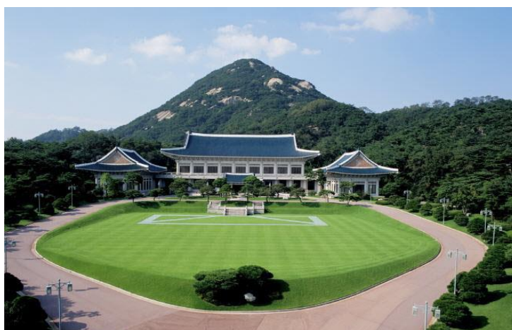
รูปที่ 39 : ทำเนียบประธานาธิบดีชองวาแด (Blue House) ซึ่งเป็นจุดที่มีวิวสวยที่สุดที่สุดในกรุงโซล ที่มา : eastasiaintel.com (2016)
