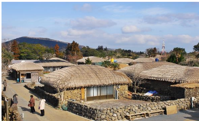
รูปที่ 87 : ภาพแสดงหมู่บ้านพื้นเมืองชงอึบ ที่ใช้ดิน และหินลาวาภูเขาไฟเป็นวัสดุก่อสร้างหลัก ที่มา : www.indtour.co.kr (2016)
