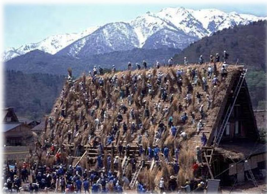
รูปที่53: การมุงหลังคาที่ต้องอาศัยแรงงานชาวบ้านประมาณ 100-200 คน ที่มา: http://shirakawa-go.org , (2559)
