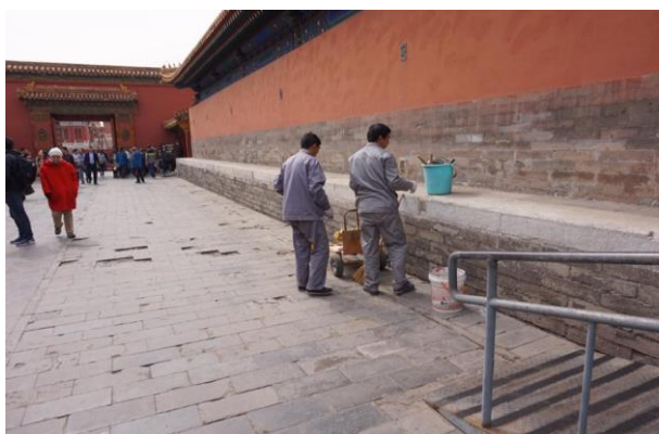
รูปภาพที่ 25 พนักงานซ่อมแซม
