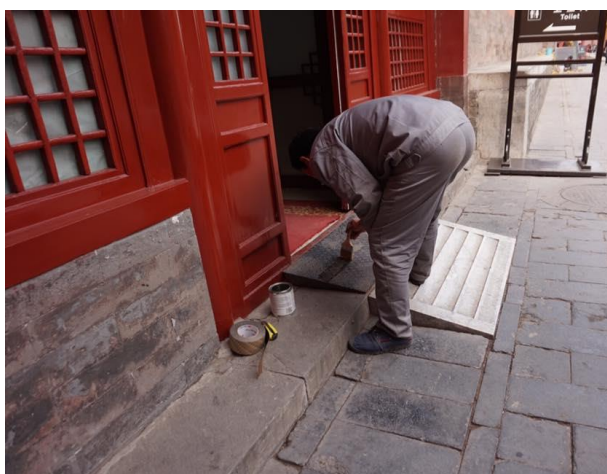
รูปภาพที่ 24 พนักงานซ่อมแซม
