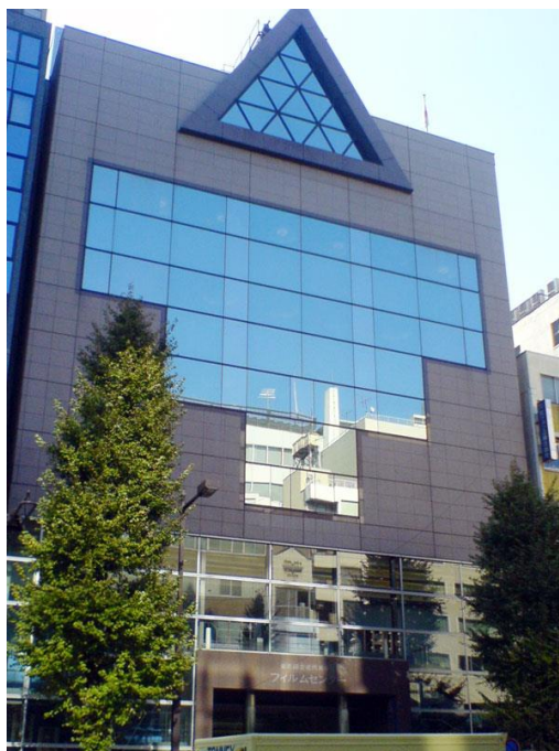
ภาพที่ 78 ด้านนอกของอาคาร National Film Center (東京国立近代美術館フィルムセンター)
