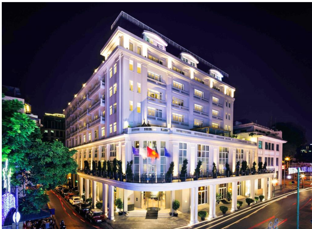
ภาพที่ 2.11 โรงแรม Hotel de l'Opera Hanoi, MGallery by Sofitel
