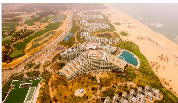
ภาพที่ 4.5 : การก่อสร้าง Vinpearl Nam Hoi An Resort & Villas ที่มา : http://bietthubiennamhoian.vn/tien-do-du-an-vinpearl-nam-hoi-an-resort-villas-thang-3-2018.html
