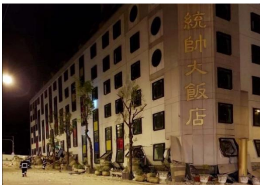
ภาพที่ 4.5 : อาคารที่ได้รับความเสียหายจากเหตุการณ์แผ่นดินไหว
