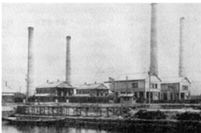
ภาพที่ 11 Neyagawa Incineration Plant ที่มา : http://www.owesa.jp/e/history.html
