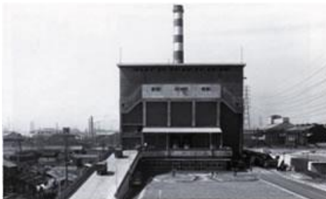
ภาพที่ 13 Sumiyoshi Incineration Plant
