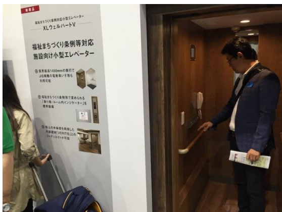
รูป 30 ลิฟต์ภายในบ้าน
