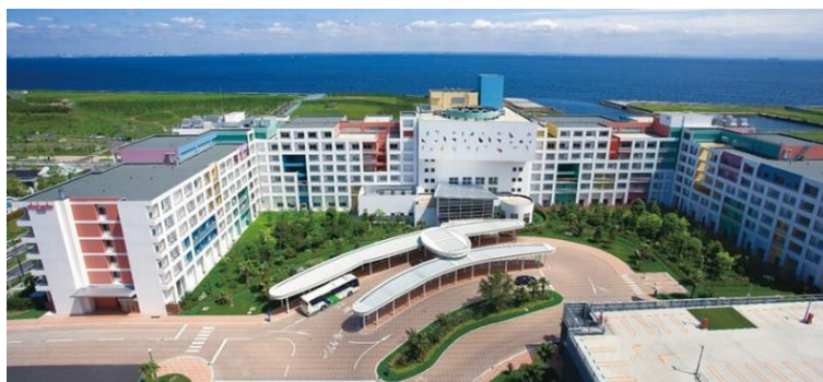
ภาพที่ 4.37 Mitsui Garden Hotel Prana Tokyo Bay
