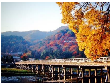
ภาพที่ 9 สะพานโทเก็ตสึเคียว (Togetsukyo bridge)
