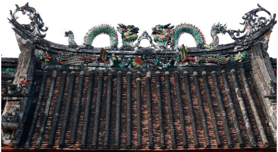
ภาพที่ 3 หลังคาของซุ้มด้านหน้าศาลเจ้าเกียนอันเกง
