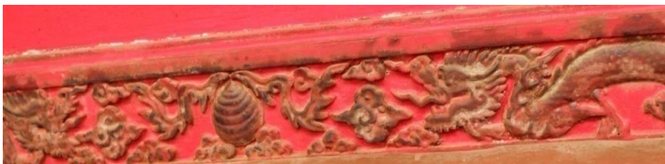
ภาพที่ 16: ลายมังกรกับไข่มุกไฟบนสะพาน (2)
