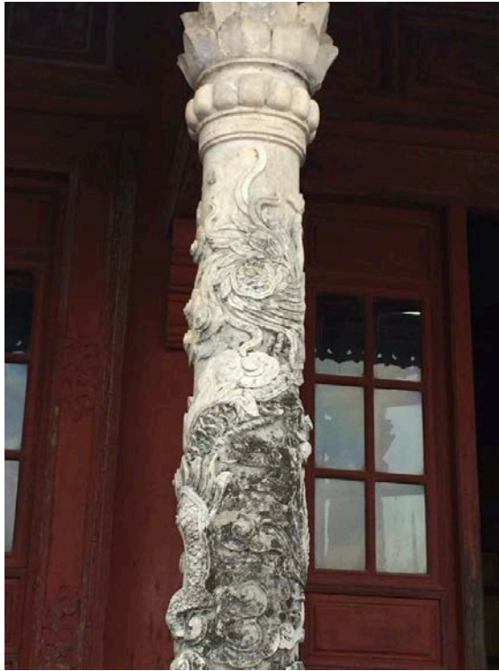
ภาพที่ 15 ลวดลายเสาหินบริเวณอาคารด้านหน้าที่แกะสลักเป็นรูปมังกรคู่กับนกฟีนิกซ์
