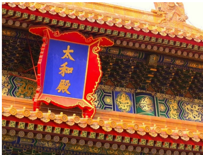
ภาพที่ 32 โครงไม้โต้วกงที่รับชายคาของตำหนักไท่เหอ
