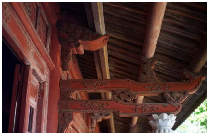
ภาพที่ 33 คันทวยรับแปของตำหนักไท่ฮวาน
