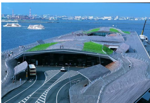
ภาพที่ 39 Yokohama International Passenger terminal จังหวัดคานางาวะ
