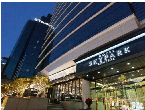
ภาพที่ 31 Hotel Skypark Central Myeongdong
