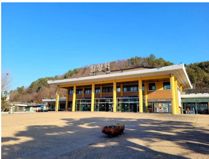
ภาพที่ 4.19 รูปภาพสถานีมียาง (Miryang Station)
