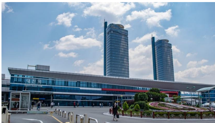
ภาพที่ 4.14 รูปภาพสถานีแดจอน (Daejeon Station)
