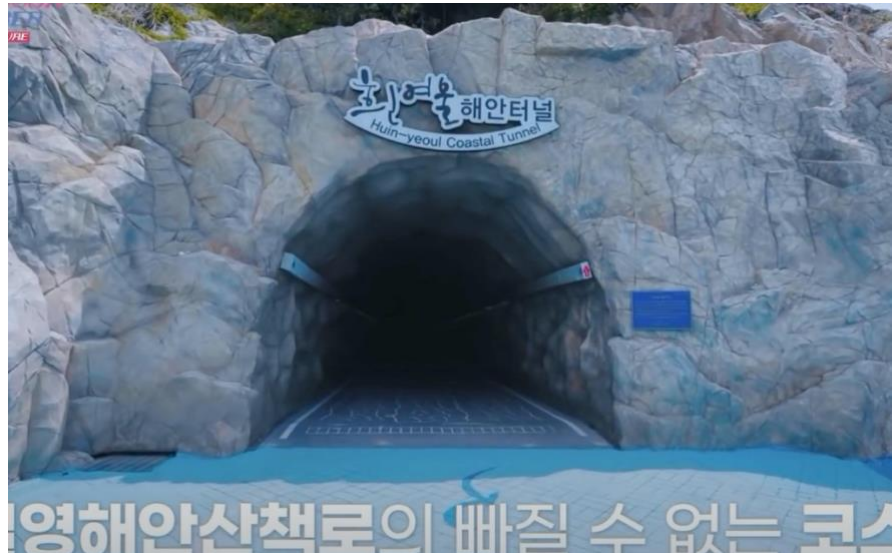
ภาพที่ 4.41 อุโมงค์ริมชายฝั่ง Huinyeoul Coastal Tunnel ที่มา : TREASURE 트레저 (2021)
