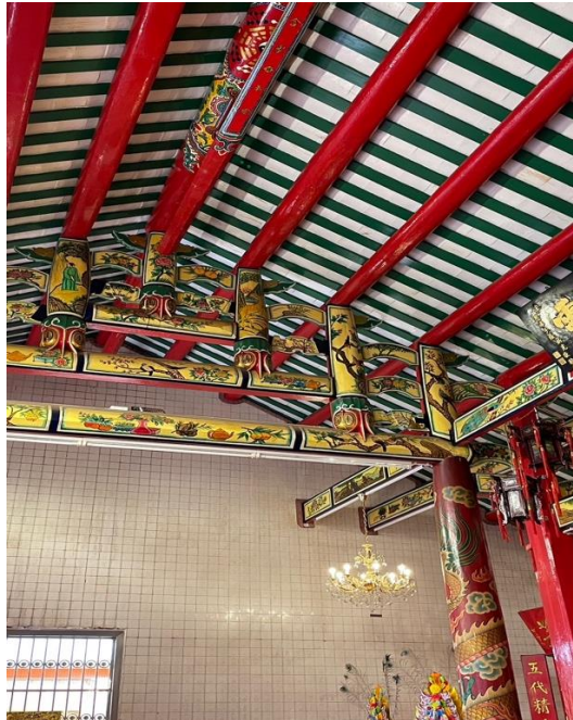
ภาพที่ 10 : โครงสร้างรองรับหลังคาภายในศาลเจ้าเล่งบ๊วยเอี้ย (ที่มา : ผู้วิจัยสำรวจเมื่อวันที่ 21 สิงหาคม 2565)
